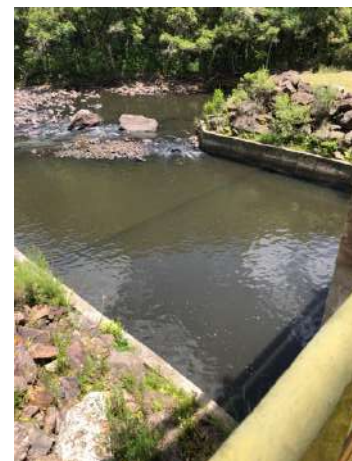
Figura 37 – Canal de fuga
