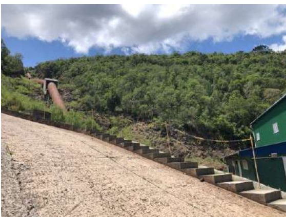
Figura 30 – Duto forçado descendo até a casa de máquinas
