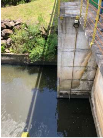
Figura 38 – Canal de fuga
