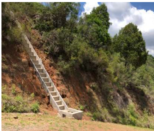
Figura 12 – Escadas para controle de erosão
