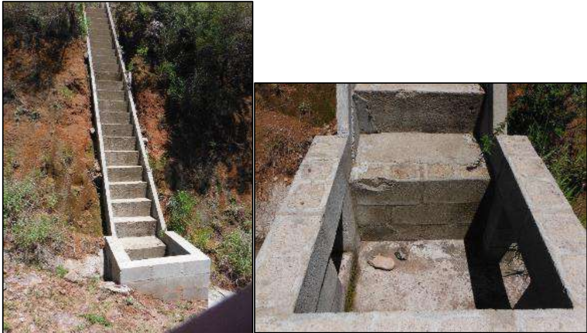
Figura 4 - Escadaria e caixa de dissipação de energia d'água.
