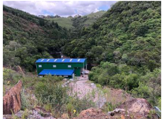
Figura 29 – Casa de máquinas
