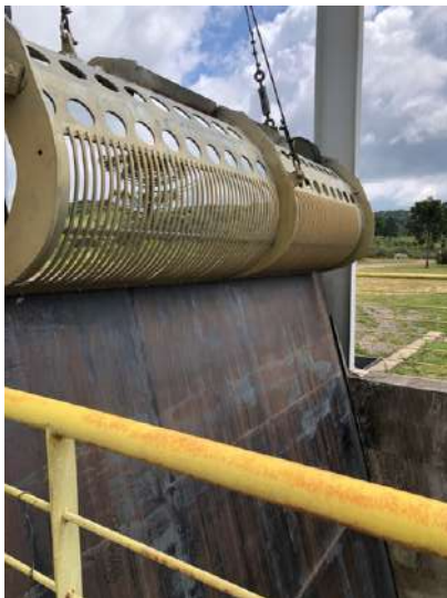
Figura 22 – Limpador de grades
