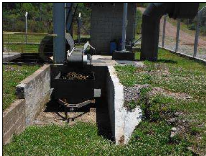
Figura 9 - Resíduos do limpa grades, armazenado temporariamente em um reboque, para posterior destinação.
