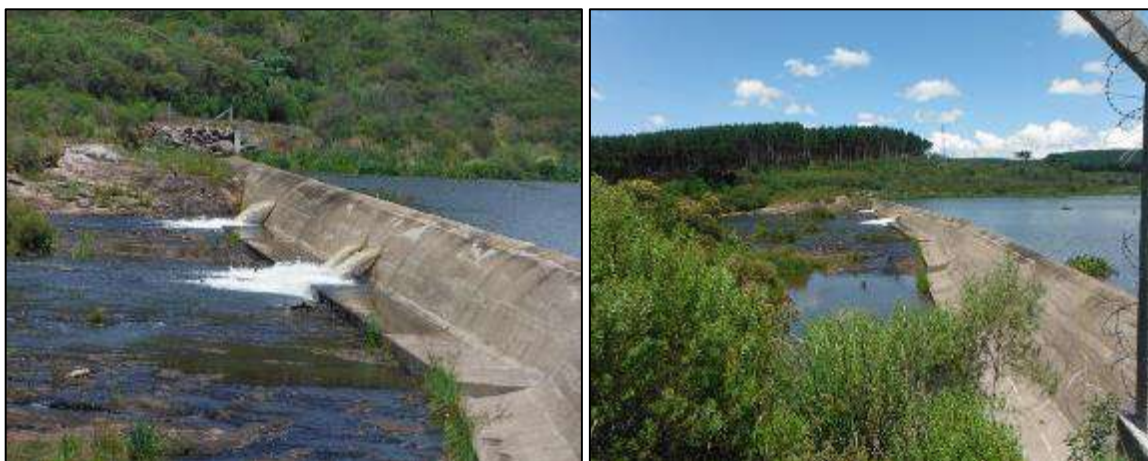
Figura 3 – Dispositivos de manutenção da vazão remanescente em pleno funcionamento.
