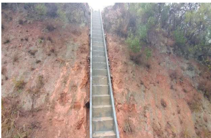
Foto 1: Implantação de escada dissipadora de energia hidráulica.
